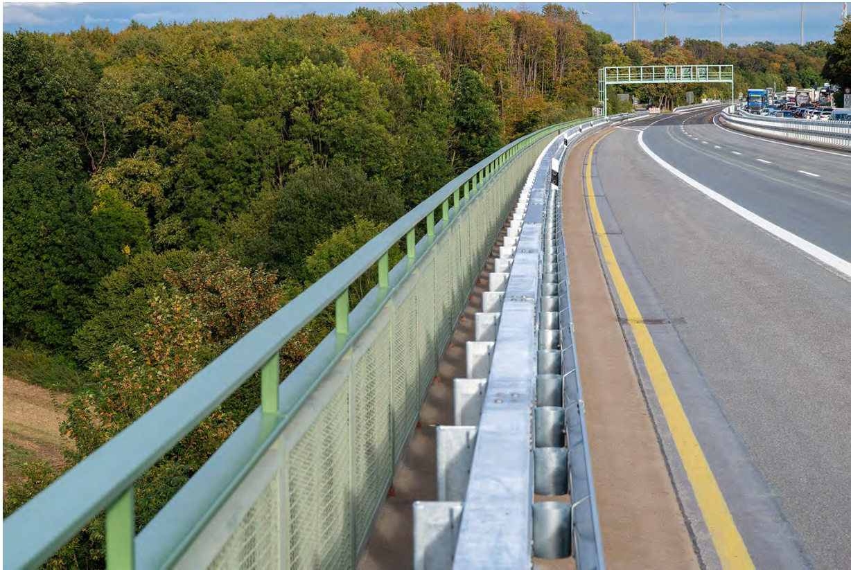
Bewährte Standardprofile im Einsatz bei einer Brückensanierung an der A44 bei Dortmund
