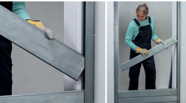
Die mit einer Dichtung beklebte, vorgelochte Seitenschiene wird links und rechts neben der Türöffnung, oder in die Türleibung, an das Gebäude gedübelt und im Fußbereich zusätzlich mit der Klebedichtung abgedichtet. Im Anschluss daran werden die Lamellen in der Länge angepasst und mit vorbereiteten Dichtungen beklebt.
